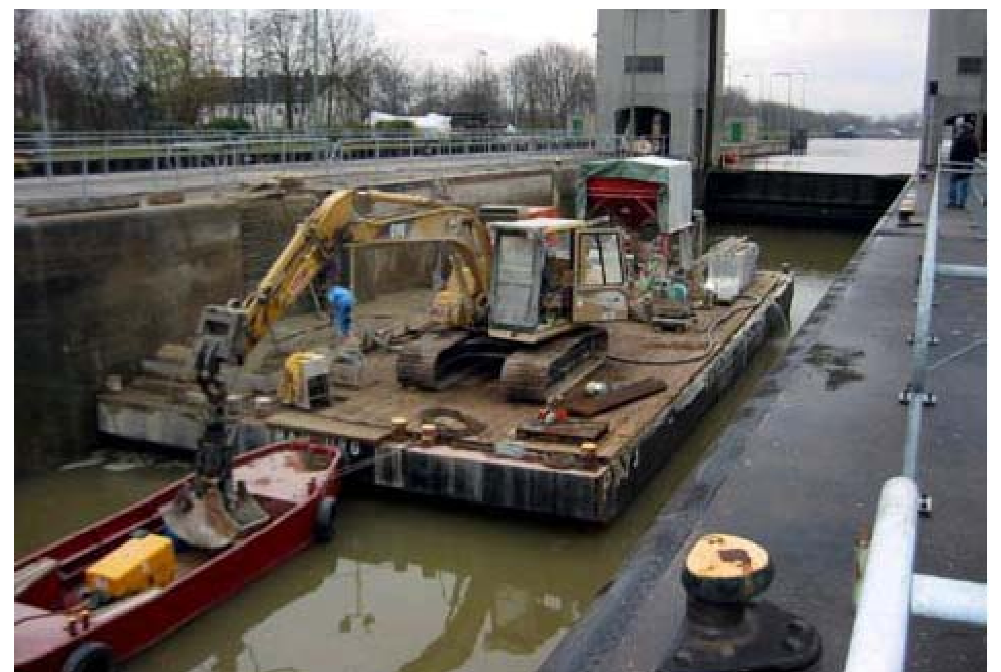
Abb. 2: Instandsetzungsmaßnahme Schleuse Feudenheim (Reschke 2009)
